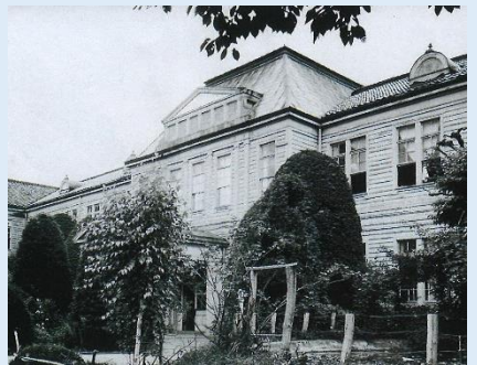
▲写真「盛岡高等女学校旧校舎」 撮影年不明 岩手県立盛岡第二高等学校提供 民子が通っていた時の校舎。
